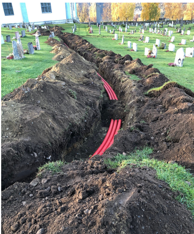
Kabelgrøft og trekkerør er fagmessig utført. Foto: Stein Olav Myhre
